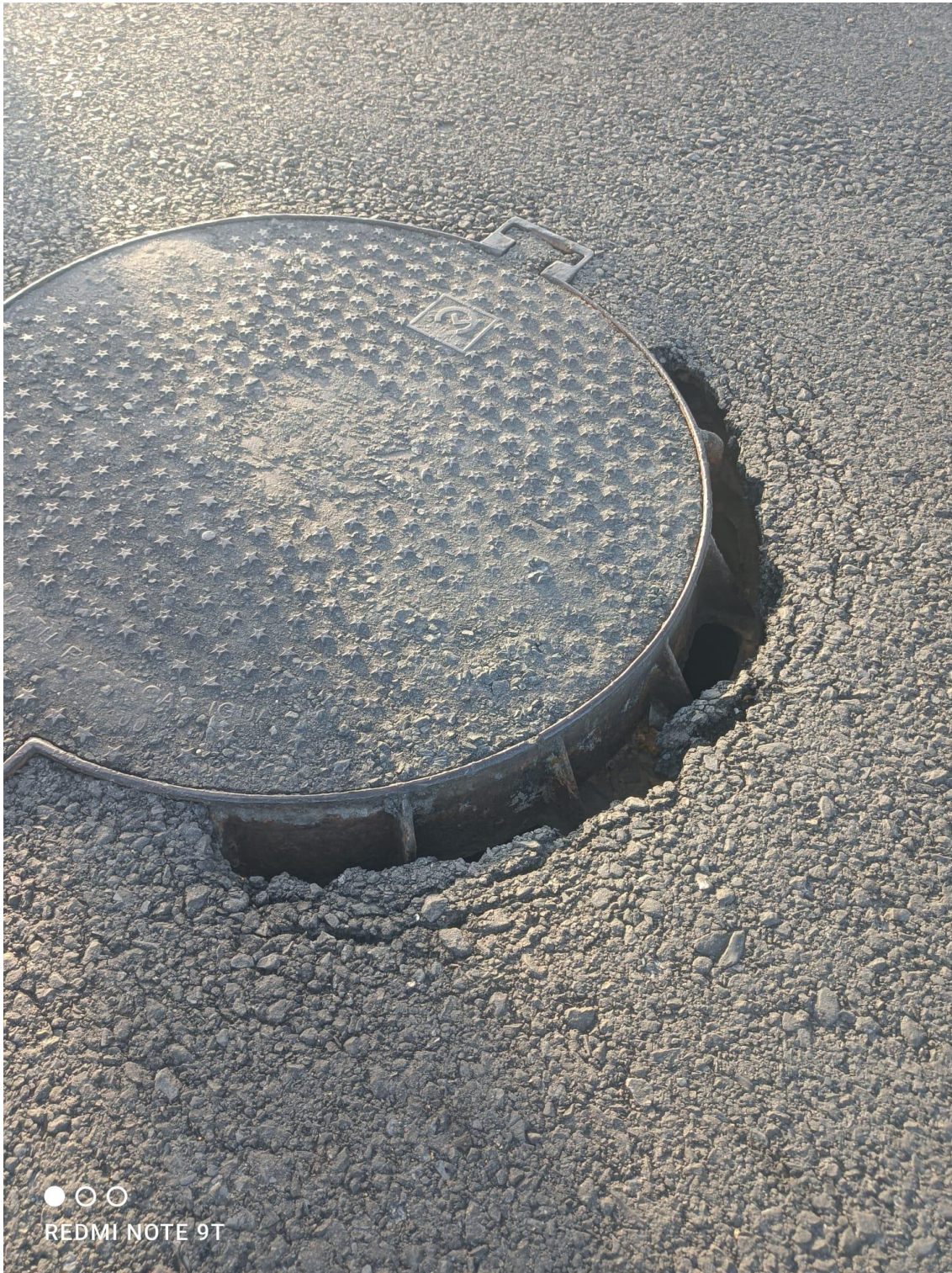
Material de obra en el acerado y sin ningún sistema de protección
