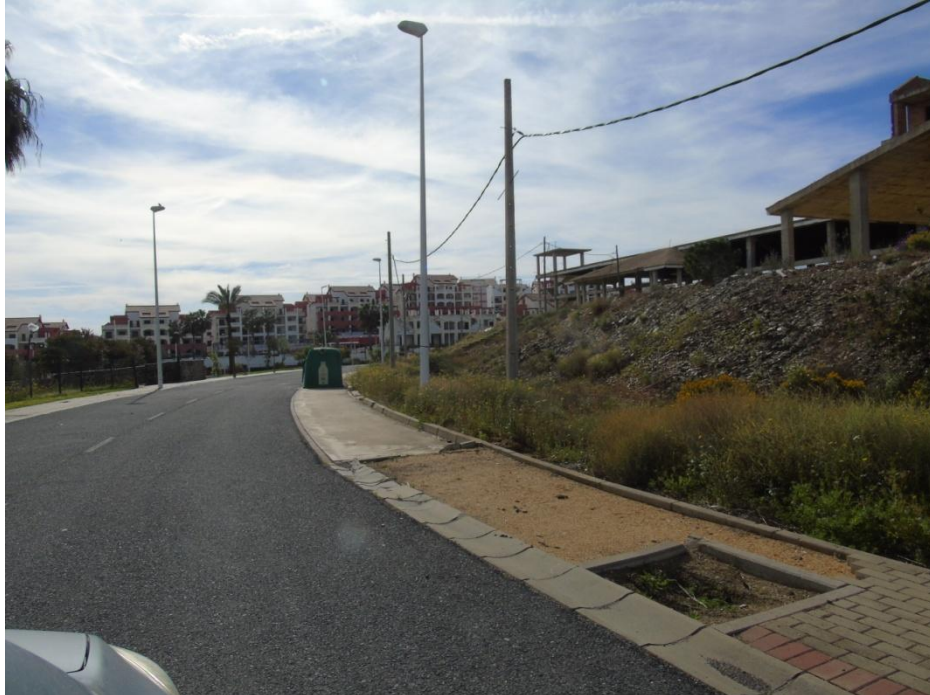
Calle Gonzalo de Berceo. Falta de acerado.
